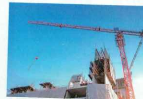
建築・建設現場
